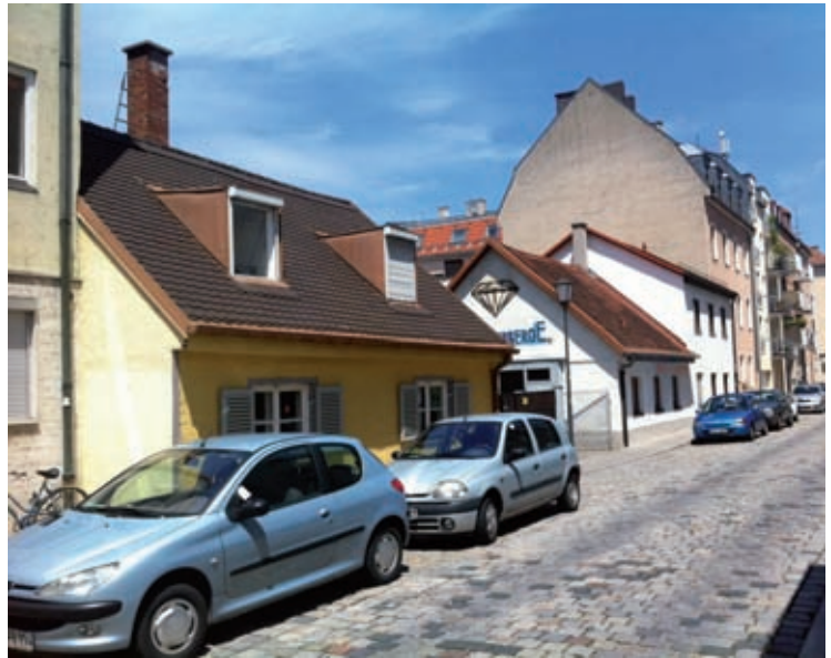
Wohnen gestern: Die Kutscherhäuser in der Birkenau sollen bald abgerissen werden, Be- und Anwohner kämpfen für den Erhalt.
