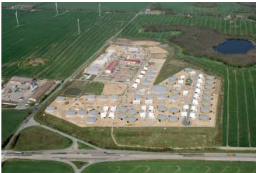
Der Biogaspark in Penkun. Nach einer Novelle des Erneuerbaren Energien Gesetzes droht der Großanlage in Mecklenburg-Vorpommern die Pleite.
